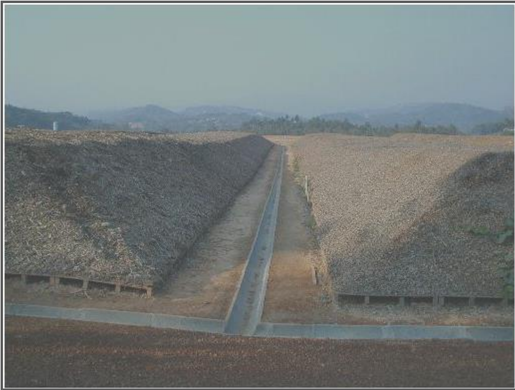
Şekil 3.1. Sızıntı Suyu Toplama Kanalları
