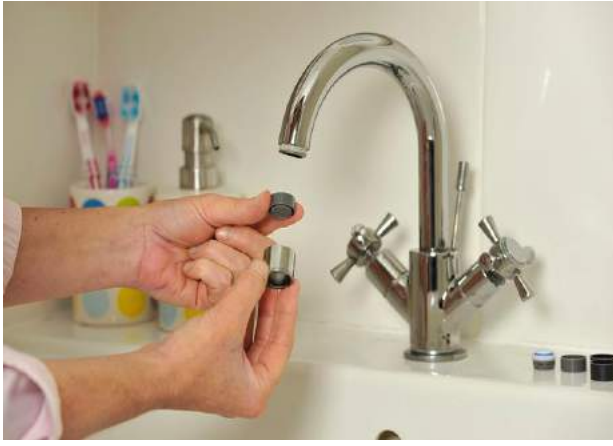
Şekil 2.1. Normal Musluklara Yerleştirilen (Düşük Akımlı) Havalandırıcılı Başlıklar
