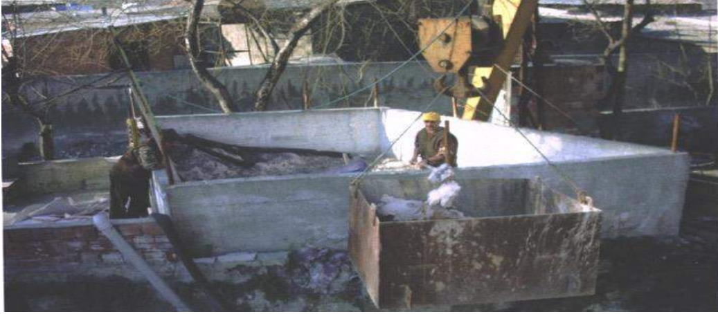
Resim 6. Çöktürme Havuzundan Sağlıksız Çamur Alınışı
